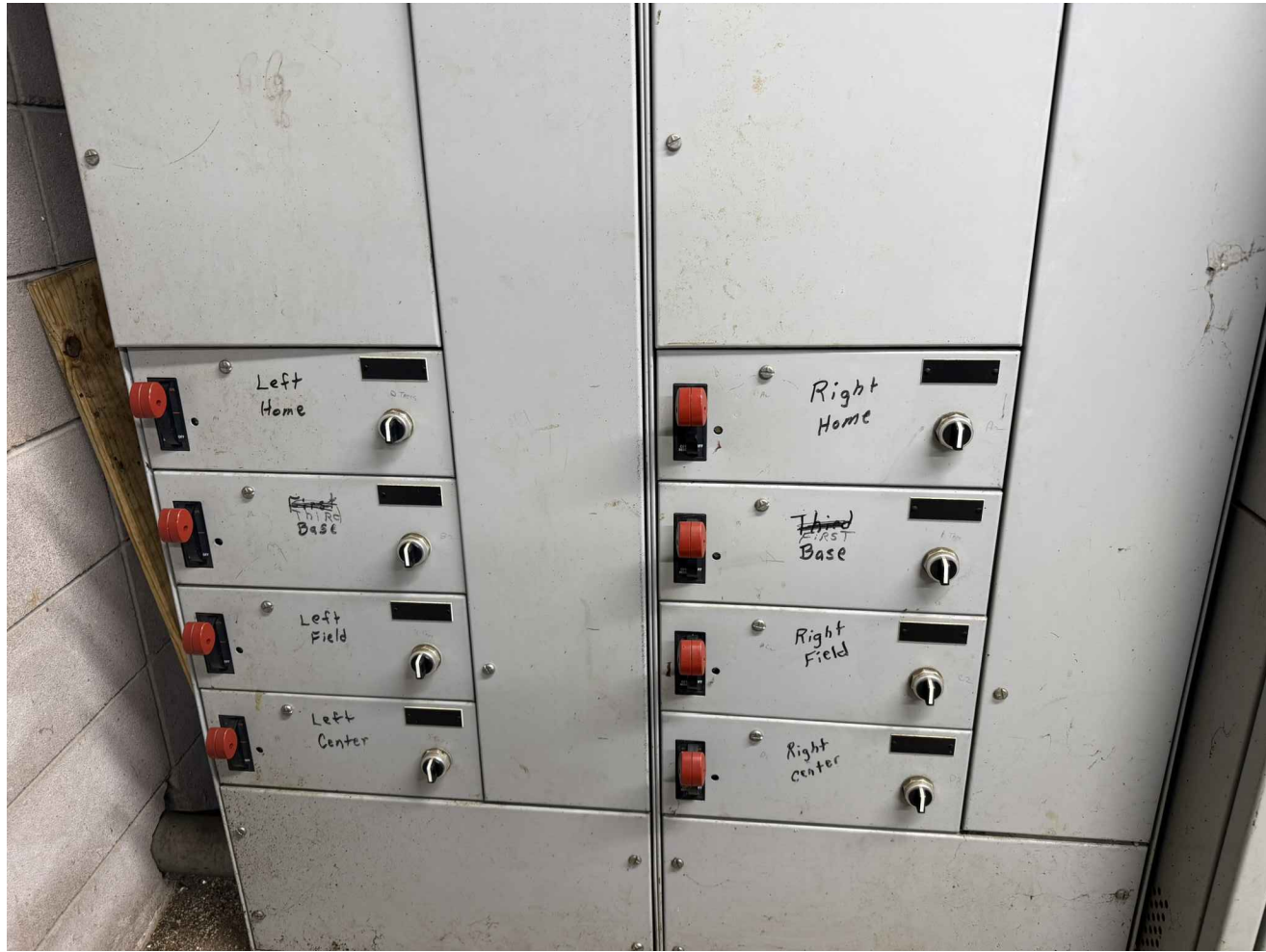
2 EXISTING MCC SERVING LIGHT POLES SCALE: N.T.S.
