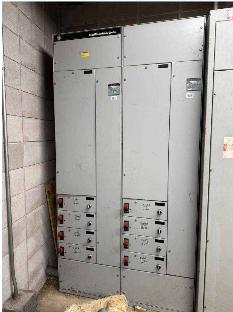
3 EXISTING MCC SERVING LIGHT POLES SCALE: N.T.S.
