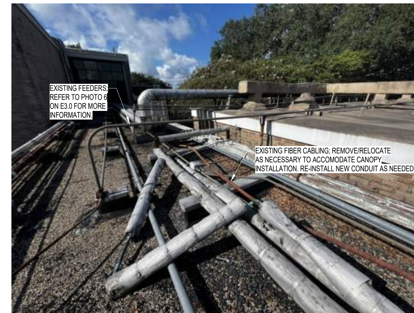
6 PHOTO 15 - CANOPY CONDUIT N.T.S.
