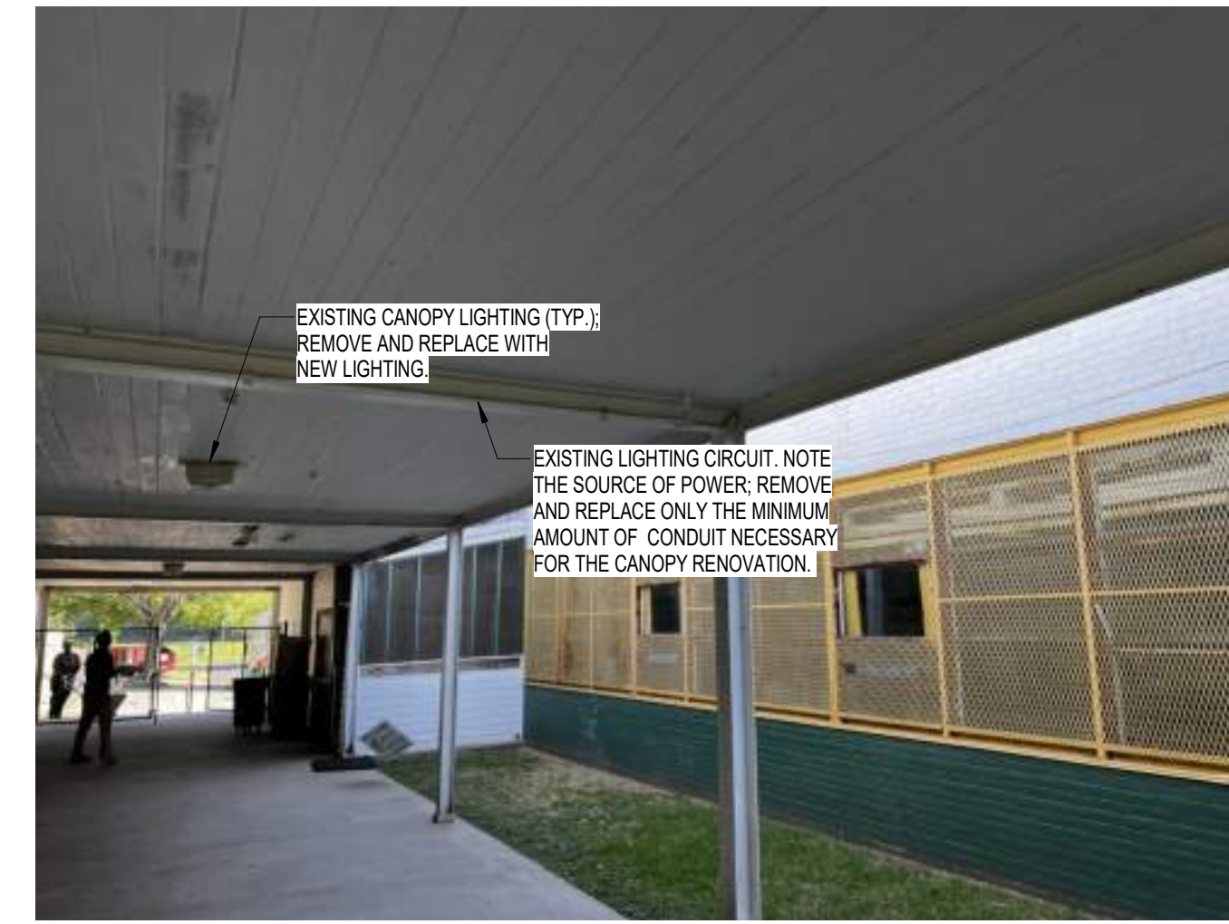
3 PHOTO 3 - CANOPY CONDUIT N.T.S.
