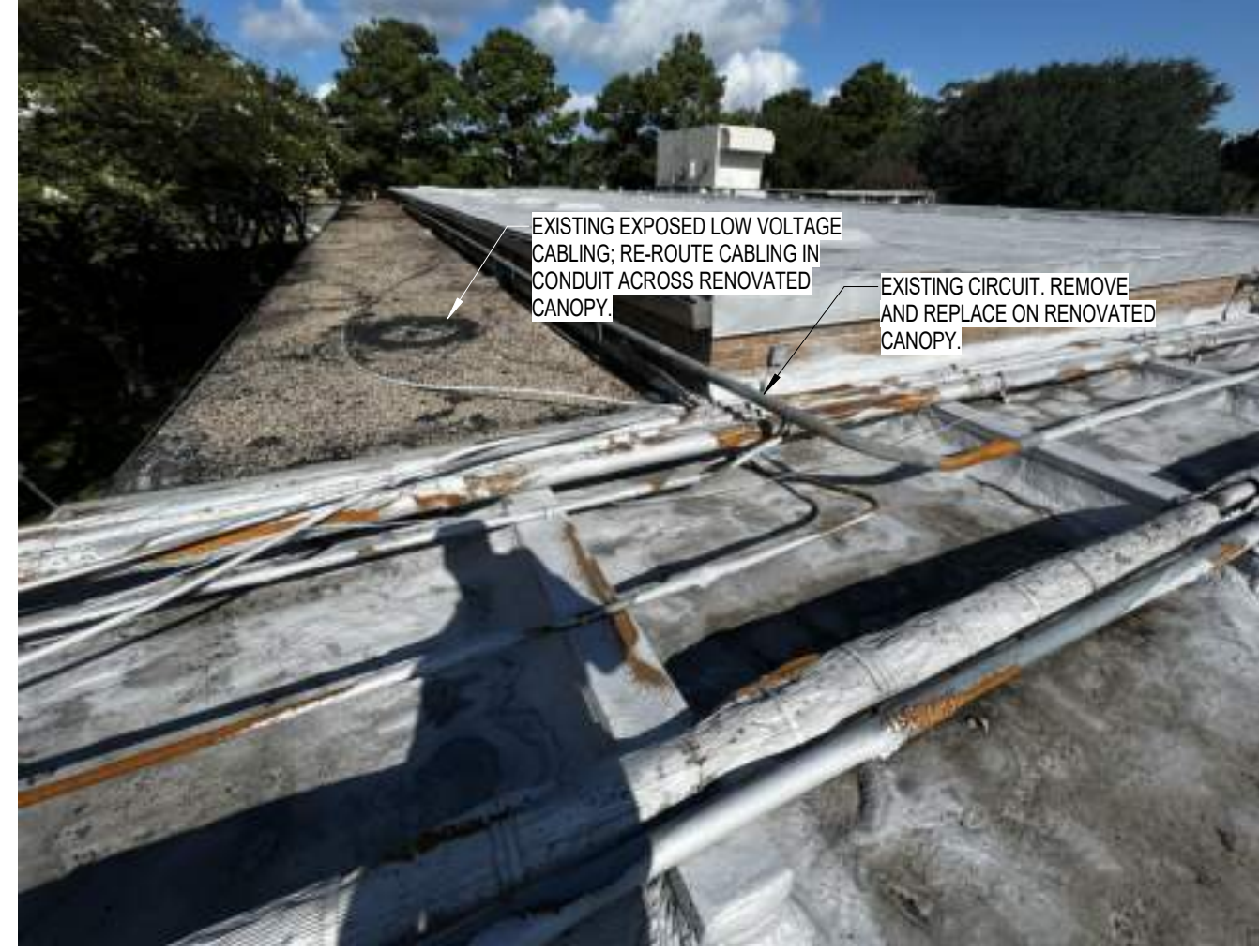
2 PHOTO 11 - CANOPY CONDUIT N.T.S.
