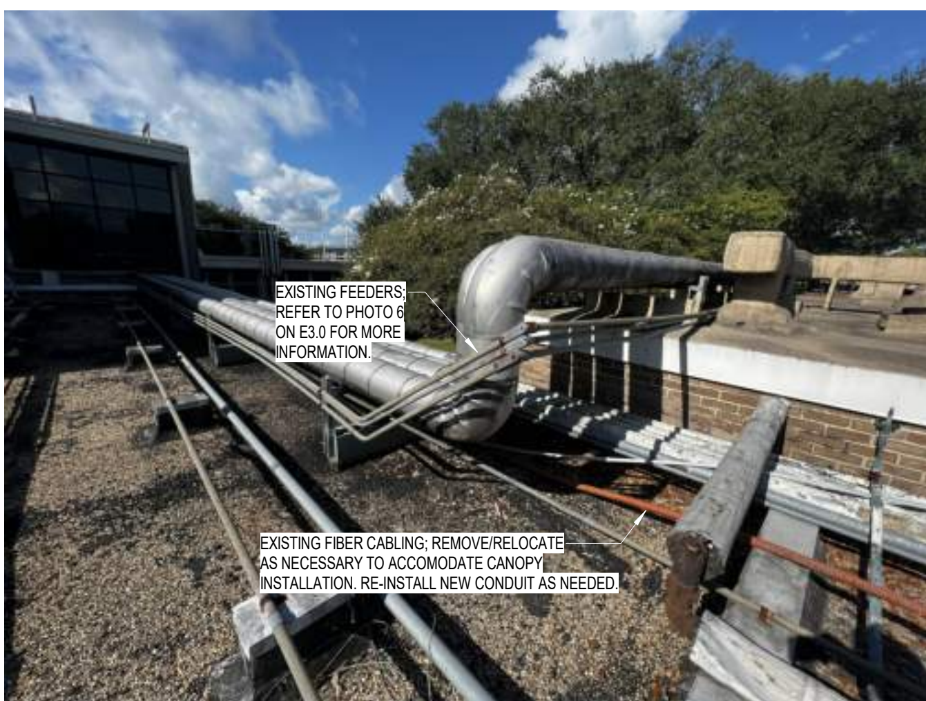
7 PHOTO 16 - CANOPY CONDUIT N.T.S.
