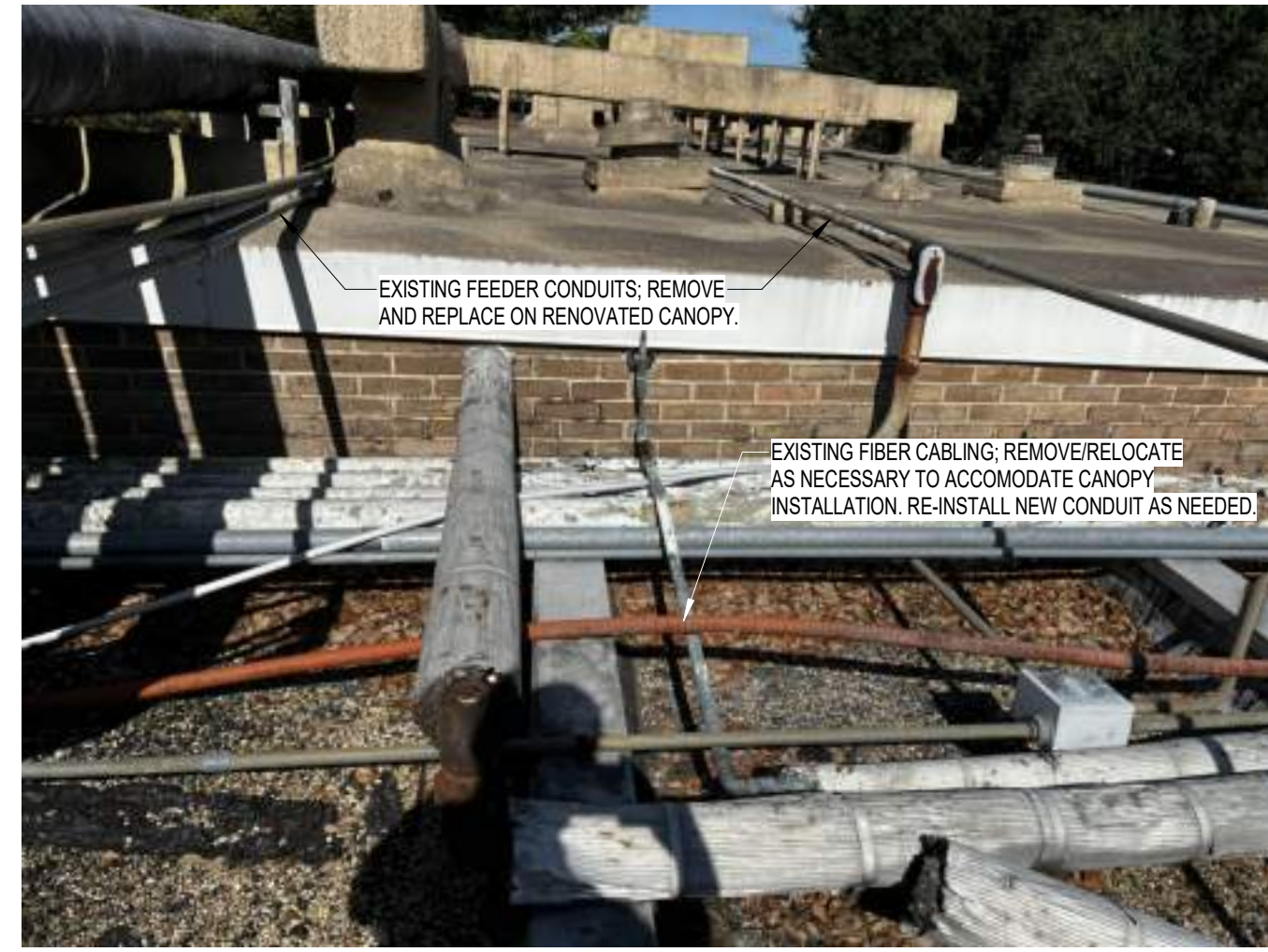
4 PHOTO 22 - CANOPY CONDUIT N.T.S.
