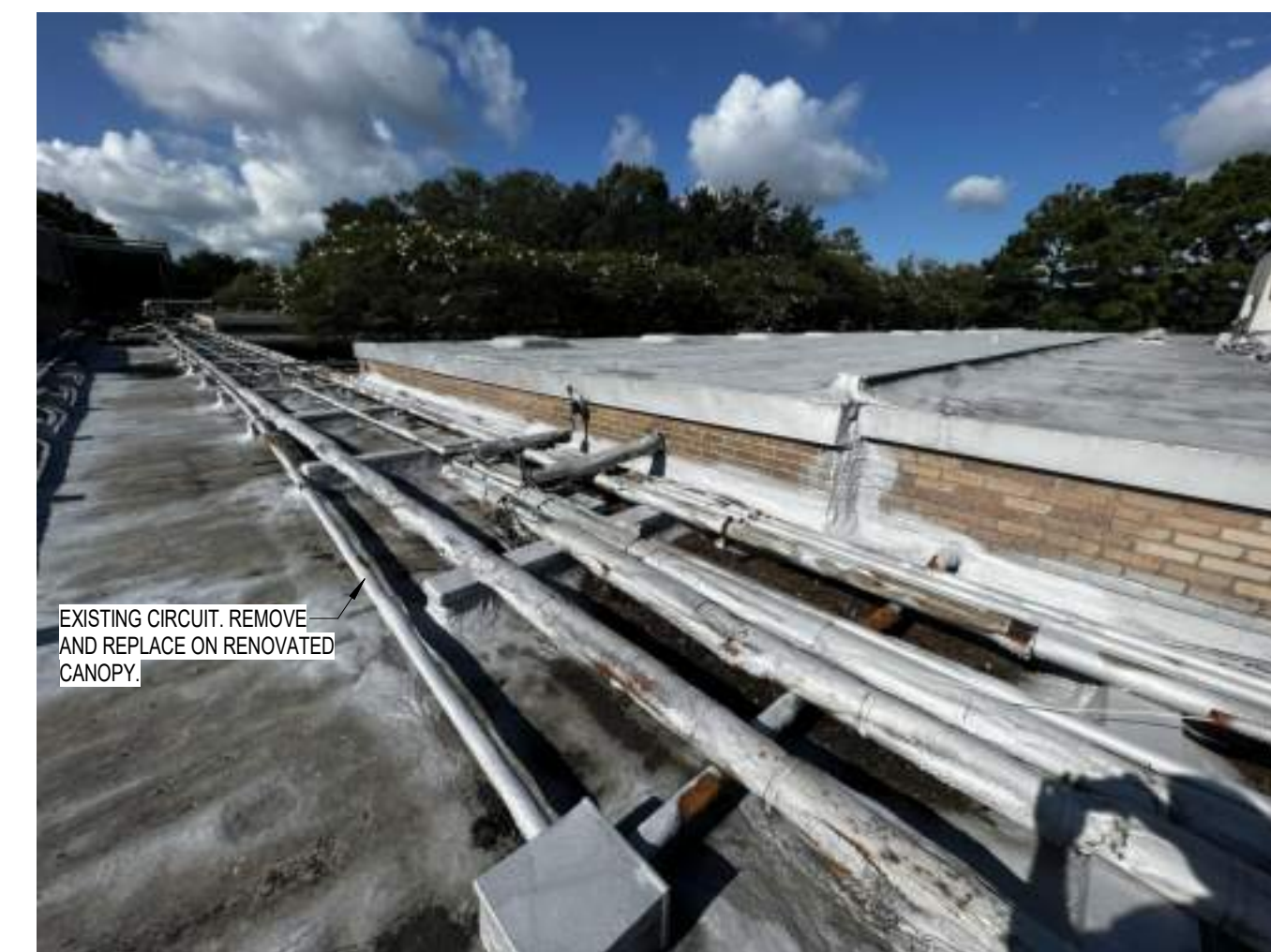
9 PHOTO 9 - CANOPY CONDUIT N.T.S.
