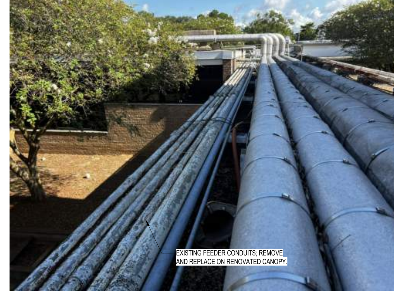
3 PHOTO 21 - CANOPY CONDUIT N.T.S.
