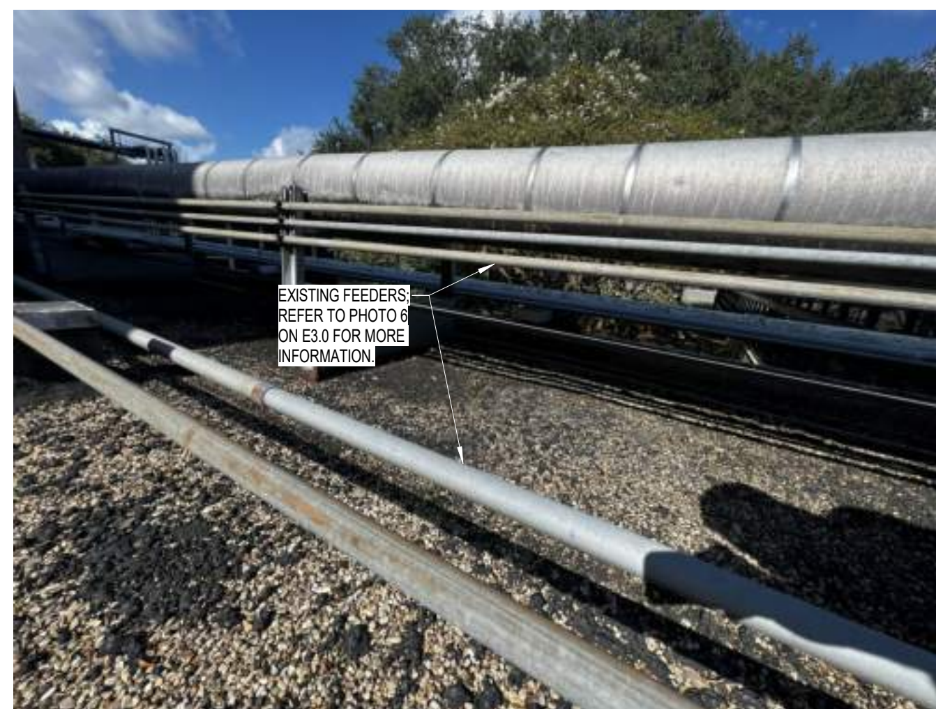
8 PHOTO 17 - CANOPY CONDUIT N.T.S.
