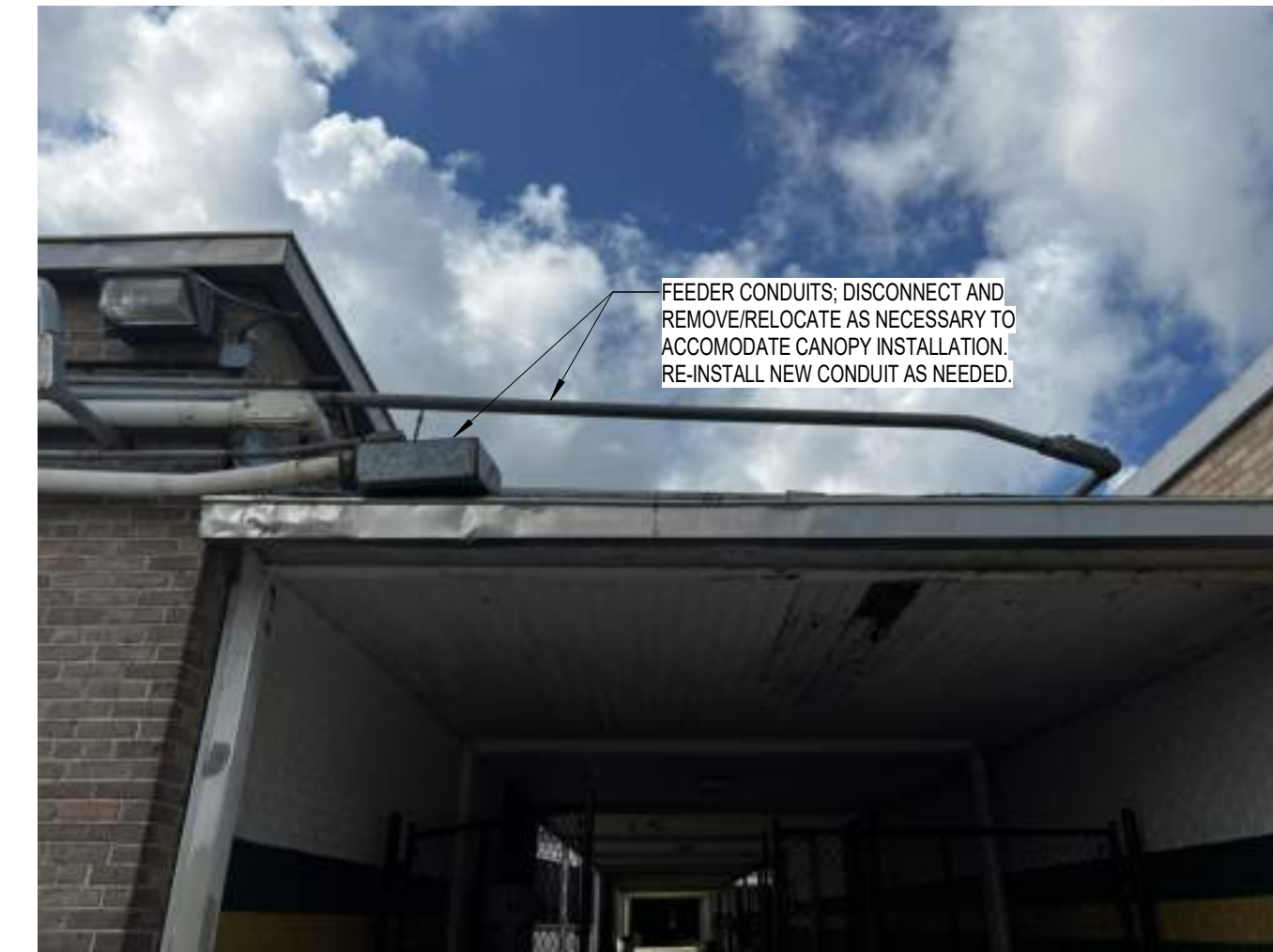
6 PHOTO 6 - CANOPY CONDUIT N.T.S.
