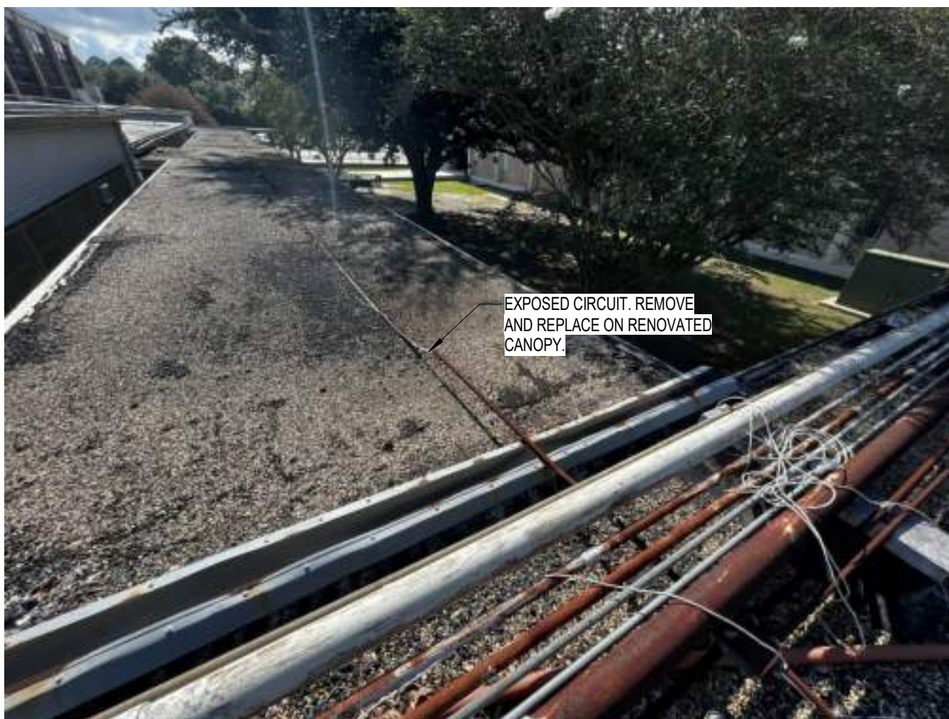
4 PHOTO 13 - CANOPY CONDUIT N.T.S.
