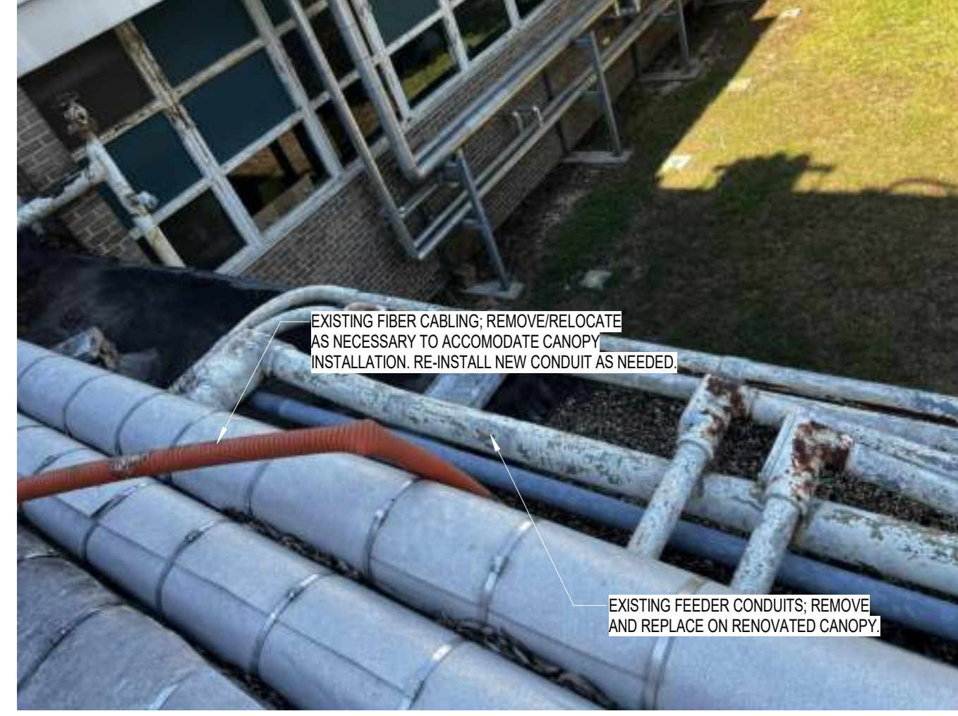
2 PHOTO 20 - CANOPY CONDUIT N.T.S.
