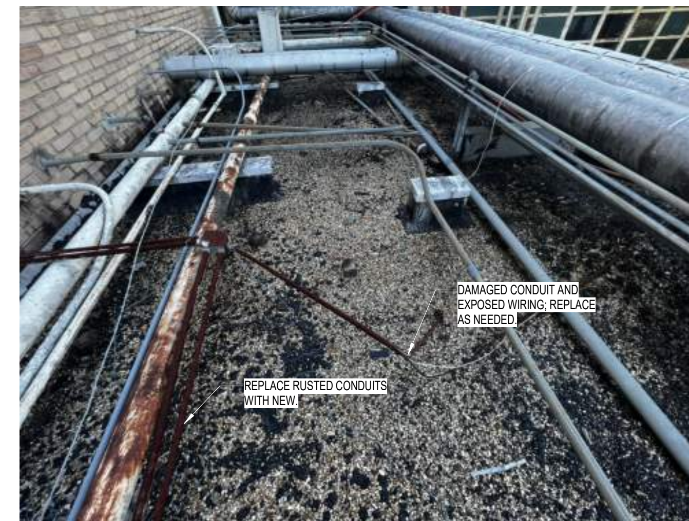
9 PHOTO 18 - CANOPY CONDUIT N.T.S.
