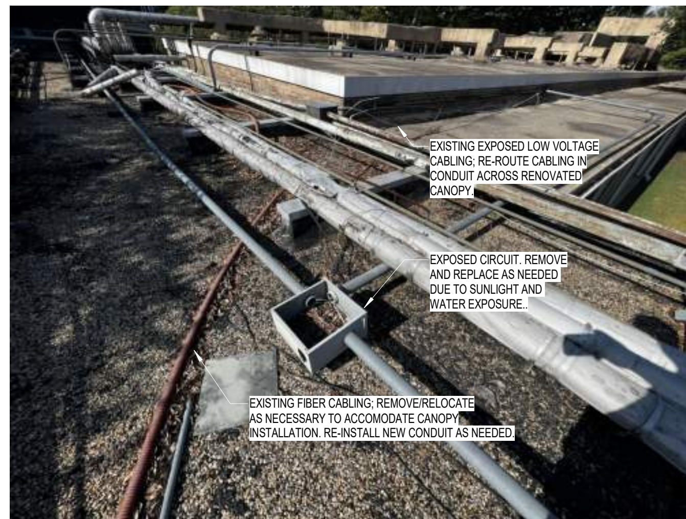
5 PHOTO 14 - CANOPY CONDUIT N.T.S.
