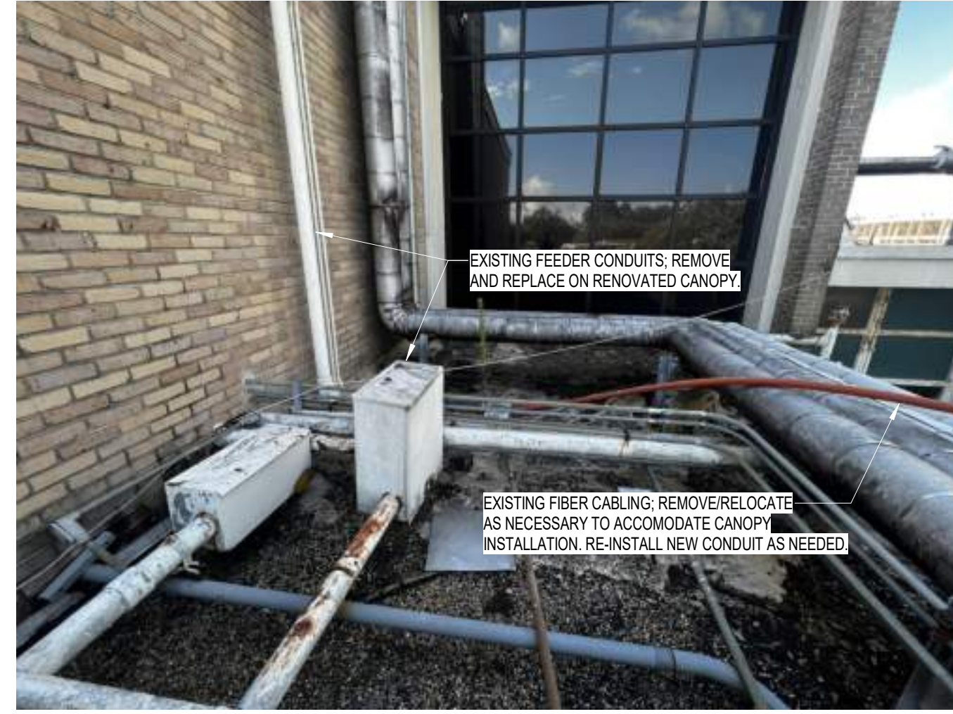
1 PHOTO 19 - CANOPY CONDUIT N.T.S.
