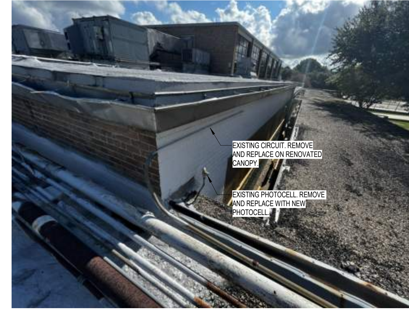
3 PHOTO 12 - CANOPY CONDUIT N.T.S.
