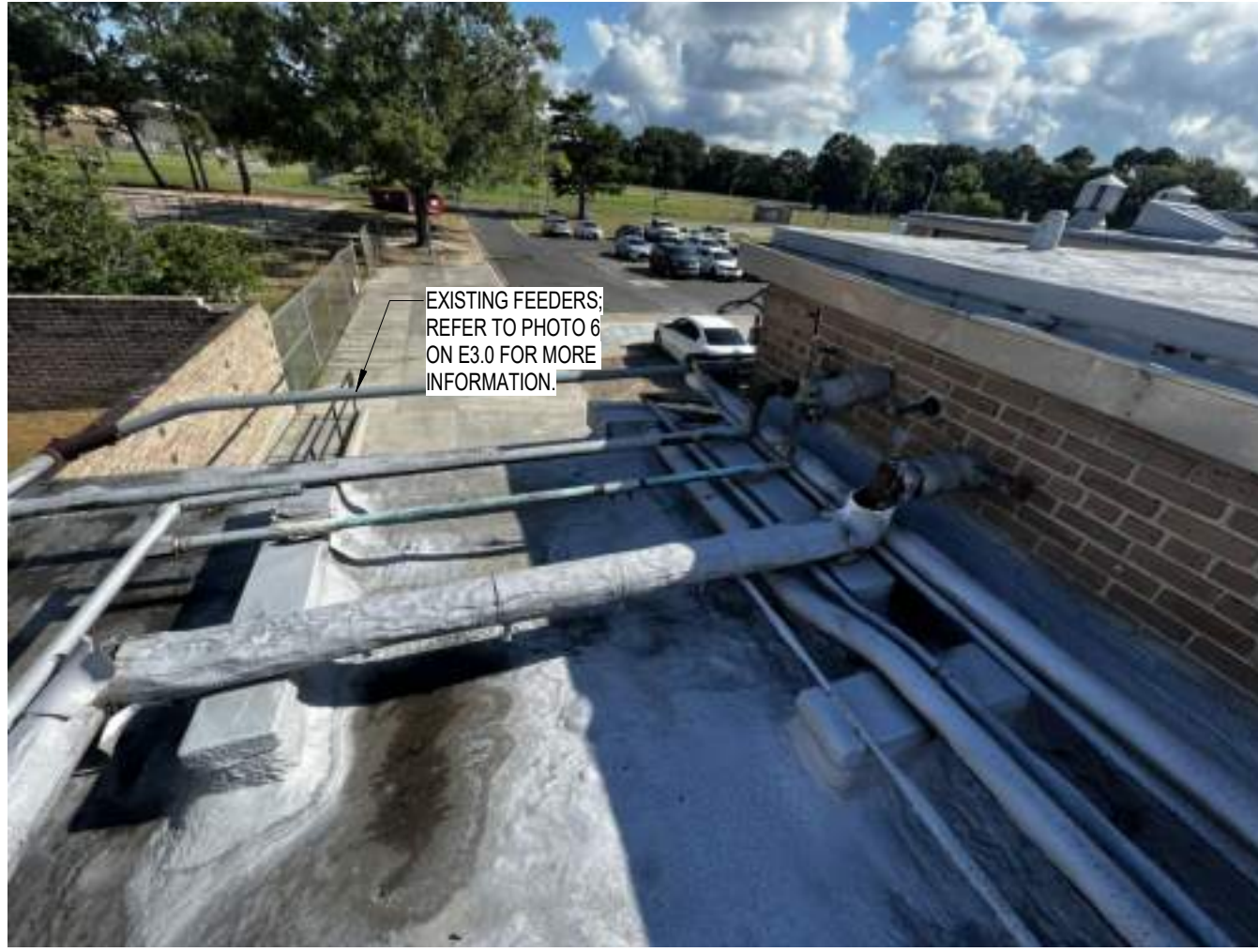
1 PHOTO 10 - CANOPY CONDUIT N.T.S.
