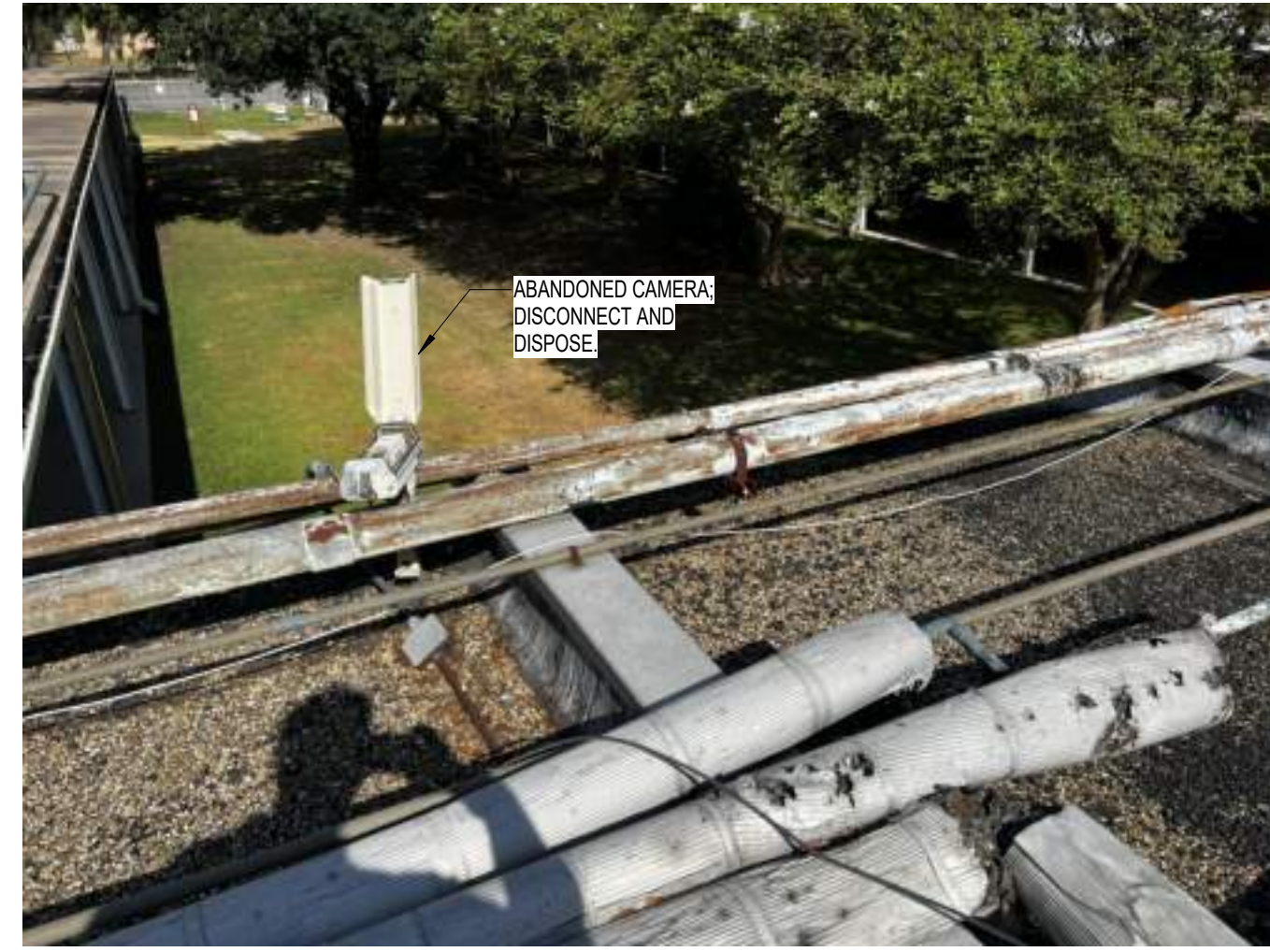
5 PHOTO 23 - CANOPY CONDUIT N.T.S.
